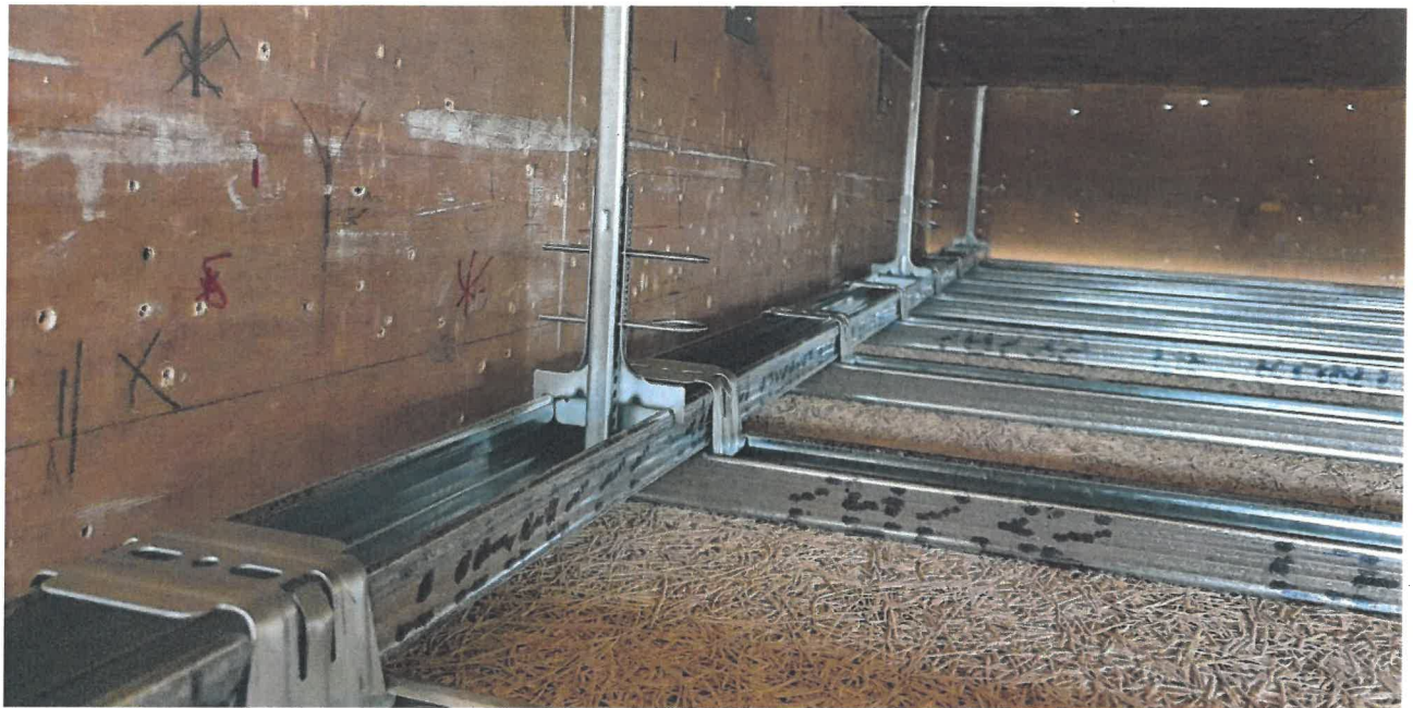
Bild 2 Detail: Abhängung "CW-W25S-P5-1200 x 600-N"
