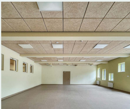
Deckenabschluss mit CEWOOD Platten mit 10 mm Fuge zwischen jeder Platte.
